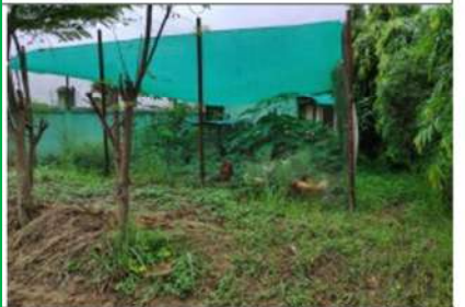
ग्रामिण कुखुरा खोर निर्माण
