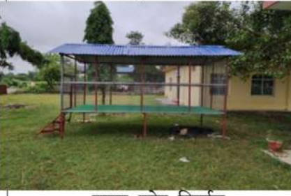
बाखा खोर निर्माण
