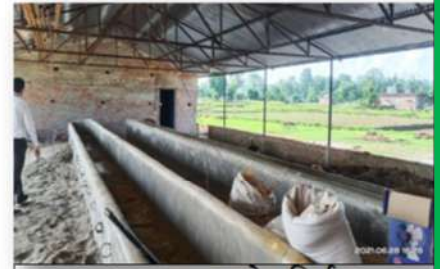
३ वटा नमुना गोठ निर्माण
